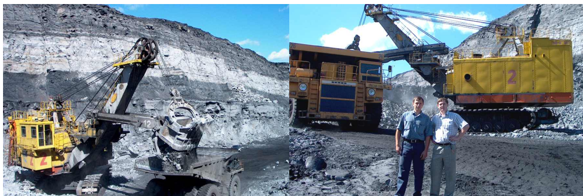
ЭКСКАВАТОР ЭКГ- 12 № 2 В РАБОТЕ
