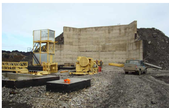
МОНТАЖ ДРОБИЛЬНО-СОРТИРОВОЧНОГО КОМПЛЕКСА (РАЗРЕЗ ШЕСТАКИ)
