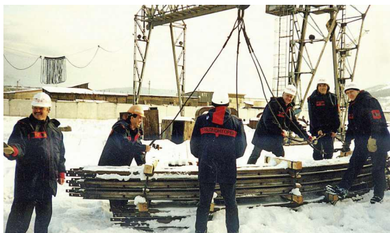
ПОГРУЗКА РЕЛЬСОВОГО КРУГА ЭКСКАВАТОРА
