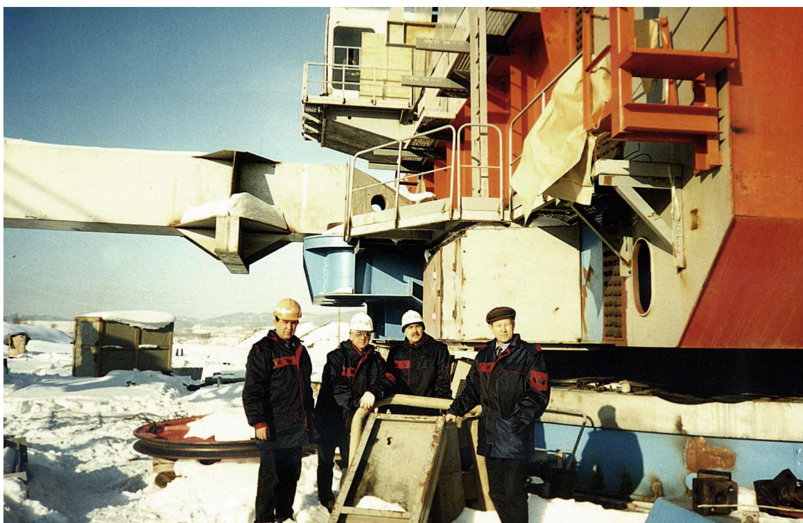
МОНТАЖ ЭКСКАВАТОРА ЭШ 20/90 № 54
