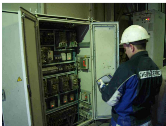
ТЕПЛОВИЗИОННЫЙ КОНТРОЛЬ ОБОРУДОВАНИЯ
