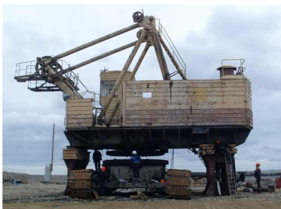
ЭКСКАВАТОР ЭКГ-8И ВО ВРЕМЯ КАПИТАЛЬНОГО РЕМОНТА
